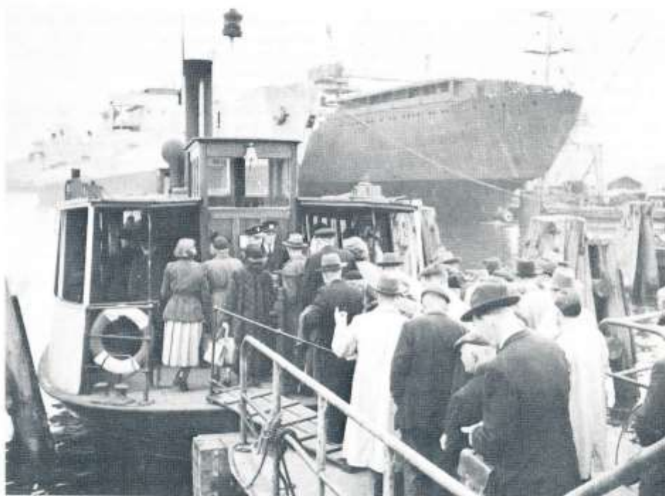
Mycket arbete återstår i FÄRJAN 4 innan hon är klar för trafik. Från ett par olika håll har framförts intresse för färjtrafik i vår. Foto omkring 1951 i Lundbyhamnen, fotograf okänd.
